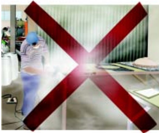
◀ Fig. 3: Situação de acabamento a seco
