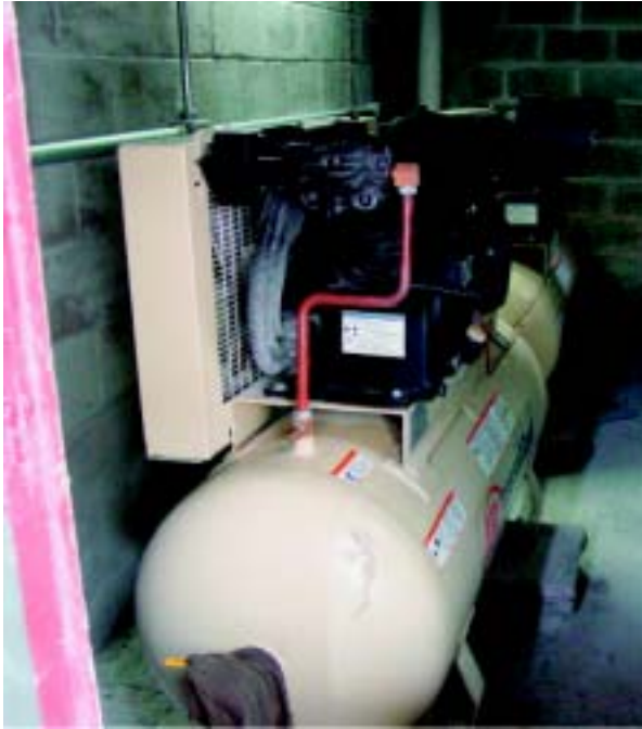
▲ Fig. 5: Compressor isolado e enclausurado
