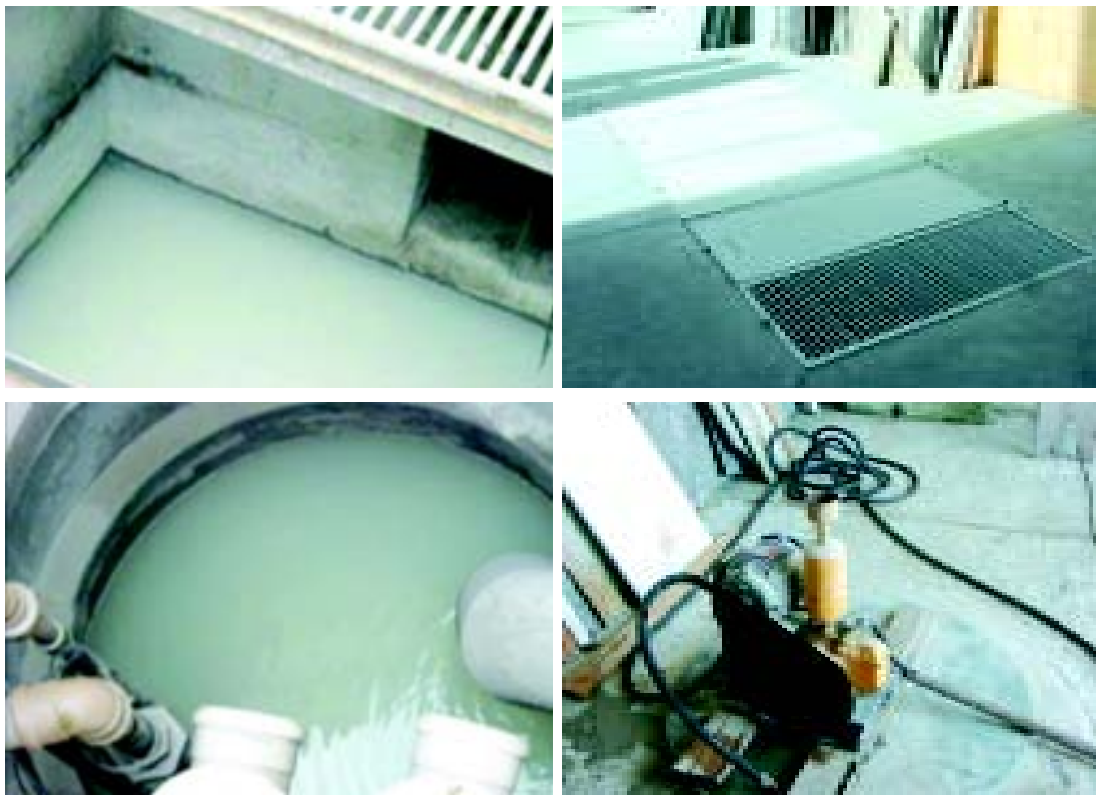
▲ Fig. 12: Partes componentes do sistema de decantação
