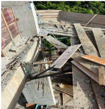
Plataforma de proteção secundária ("bandeja secundária") sem forração completa, sem manutenção e com acúmulo de materiais
